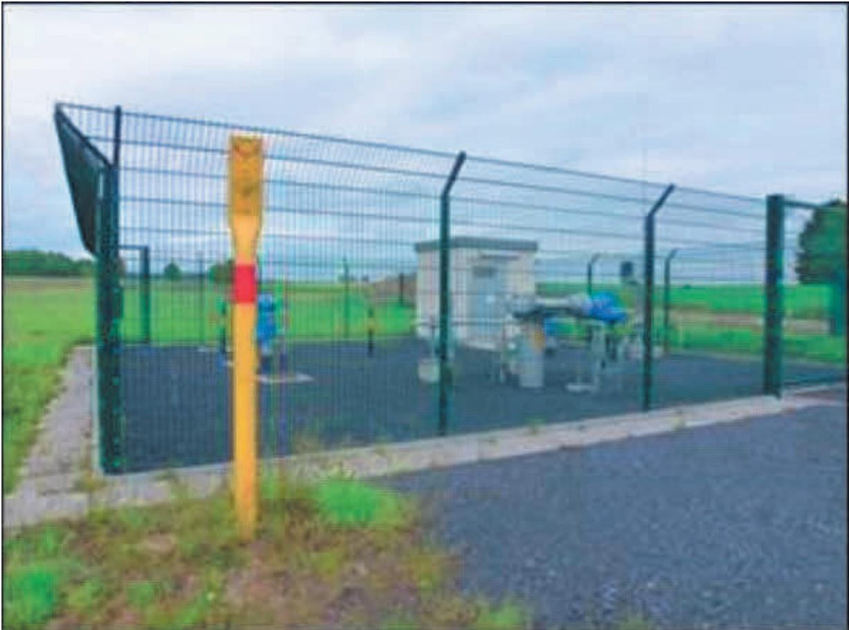
**Abbildung 8:** Beispielbild einer Armaturenstation
