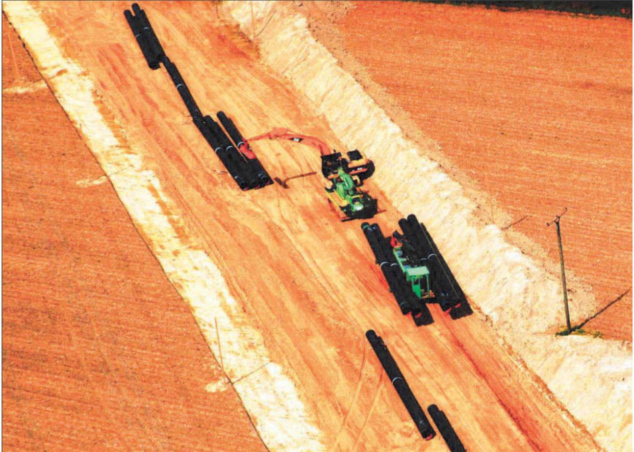
**Abbildung 11:** Rohrausfuhr im Arbeitsstreifen
