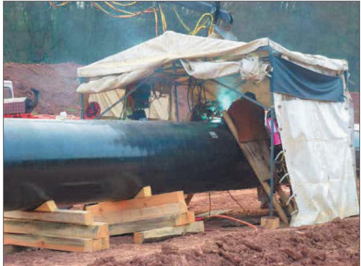
**Abbildung 12:** Verschweißen der Rohre zum Rohrstrang
